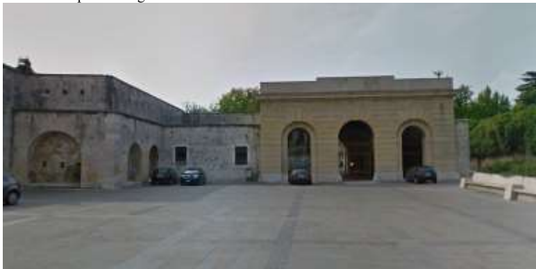
facciata interna della Porta, 1840
